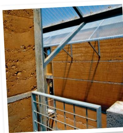
Comme pour les bétons, le fait que la terre soit un matériau composite constitué de grains de différentes tailles (de la poussière au gravier) lui confère la solidité nécessaire aux structures porteuses.
